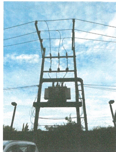
รูปภาพที่ 2.27 หม้อแปลงไฟฟ้า
